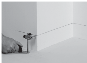
Marker gulvbelægningshøjden med en linje på væggen...
