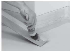
Påfør lim på gulvet og på væggen op til linjen.
